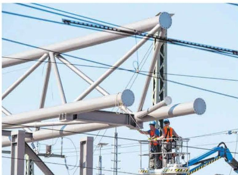
Die dreiseitige Stahlkonstruktion schwebt per Funk-Anweisung langsam ein und muss exakt in die Halterung der Stützen passen.
